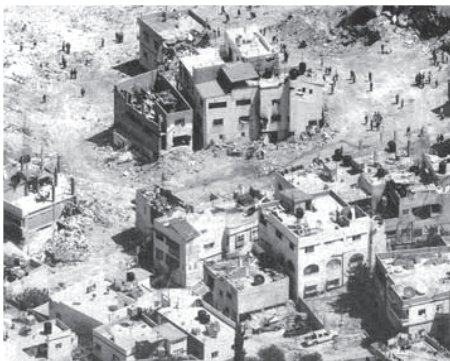
مرکز جنین پس از کشتار اخیر اسرائیل کل خیابان‌ها ناپدید شده‌اند یعنی تخریب و با خاک یکسان شده و زیر پاره سنگ‌ها دفن شده‌اند. ارتفاع تل پاره سنگ‌ها چنان بالاست که طبقات پایین ساختمان‌ها که هنوز دست نخورده‌اند زیر پاره سنگ‌ها ناپدید شده‌اند.
