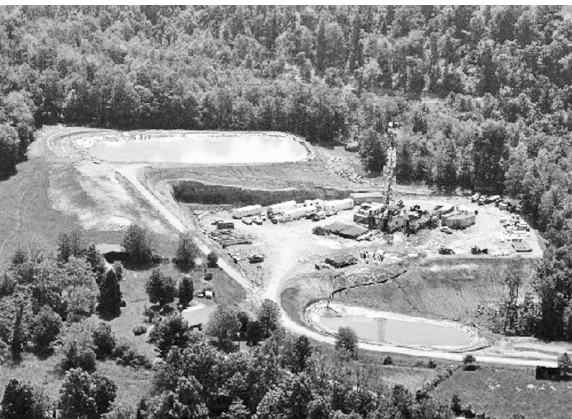
عملیات حفاری شل گس در غرب ویرجینیا
